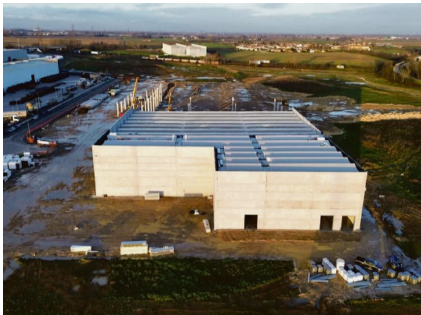
A sinistra alcuni lavori dell'impresa nella zona di Valdaro a Mantova. A destra la realizzazione di una ciclabile. In alto, altri cantieri dell'azienda edile castiglione
